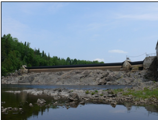
Le barrage de la centrale Glen Ford Crédit photo : Patri-Arch
